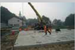
Příprava základů pro posazení montovaných staveb
